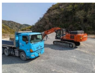
↑ 巨大な重機で掘削&運搬
