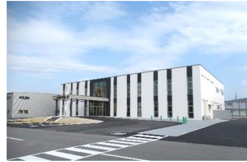
↑今年5月に完成した徳山工場の新事務所
