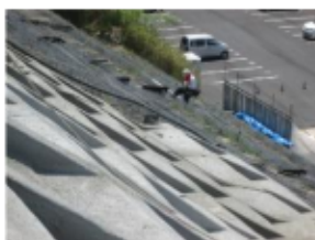
↑のり面保護工事
